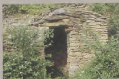
Une caborne appuyée à un mur d'enclos
