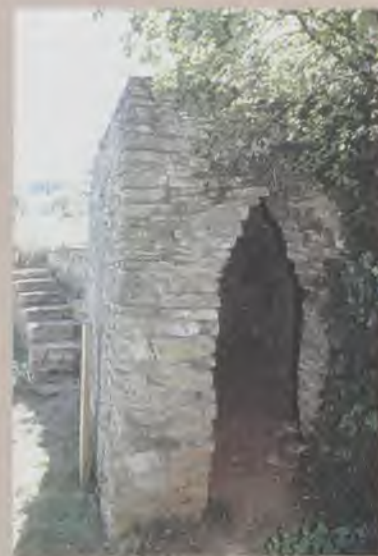
Caborne intégrée à un mur de soutènement
