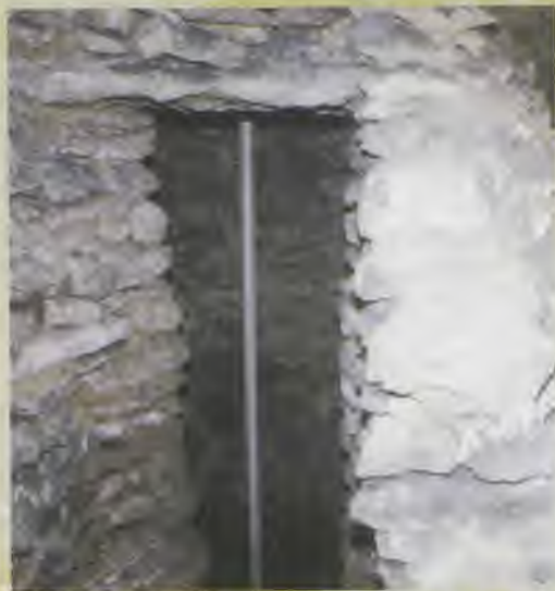
Un puits dans la galerie sèche du grand captage, à Saint-André, commune de Saint-Didier-au-Mont d'Or. Il est traversé par un tuyau qui montait dans une remise de ferme.
