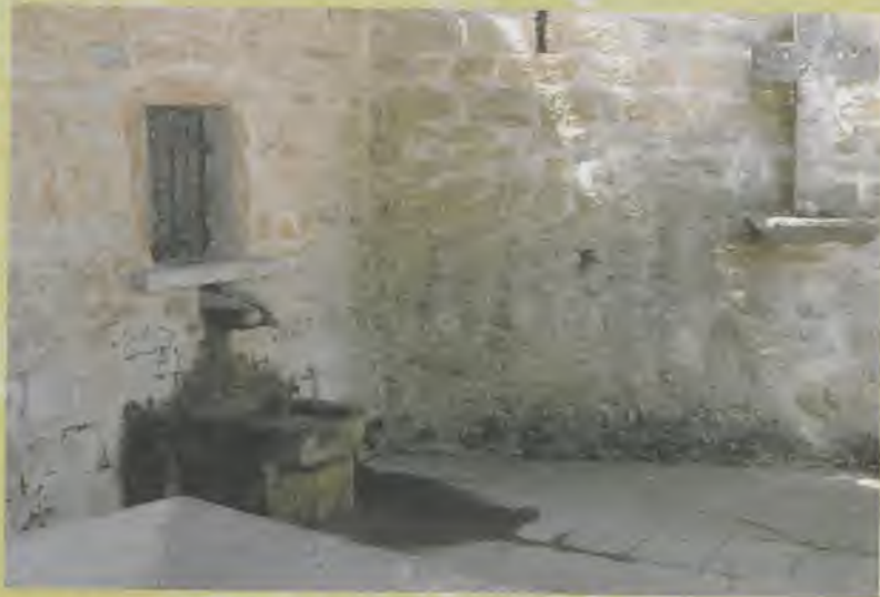
Lavoir de Braizieux (station n°6), à proximité du Vieux-Collonges. L'eau arrivant au lavoir est prélevée dans une galerie par un "séparateur" : c'est un barrage avec un déversoir en direction de la sortie. La croix à l'entrée du souterrain rappelle combien l'eau et le signe de la divinité ont toujours été inséparables.
