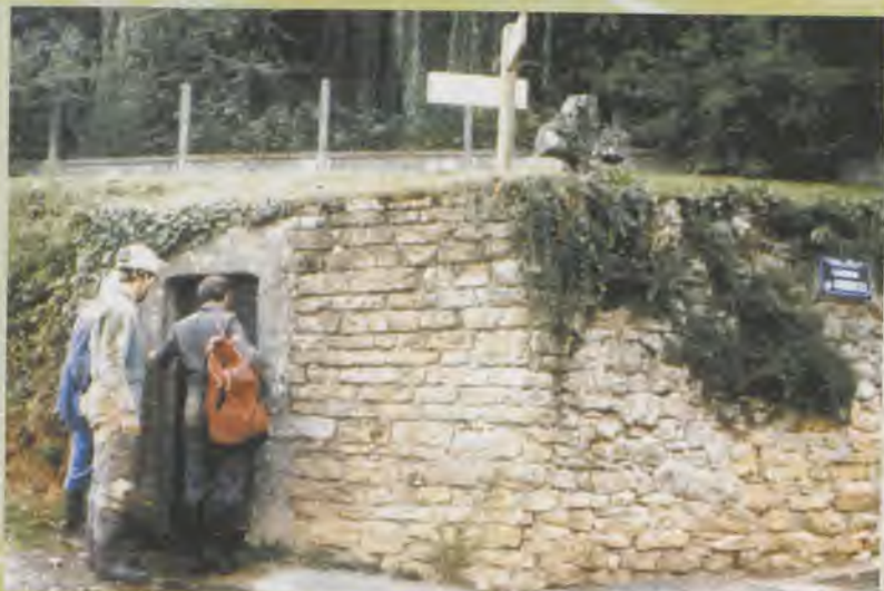
Des spéléologues pénètrent par la porte de la galerie de Montgelas, au-dessous de laquelle sort l'eau du captage qui alimentait, par des tuyaux de terre cuite, tout le Vieux-Collonges.
