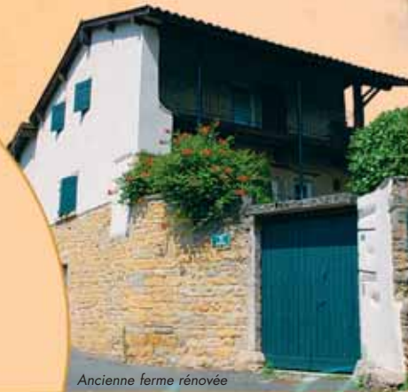
Ancienne ferme rénovée
