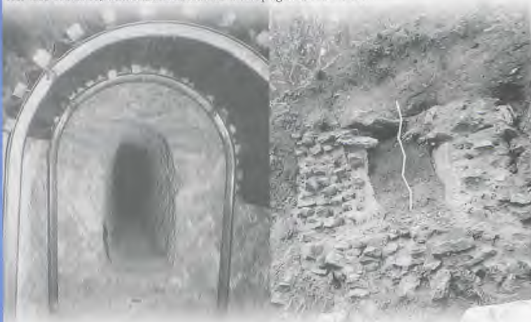
Exemple d'aqueduc profond : l'archinière des Monts d'Or en cours de travaux à la Fuchardière (Saint-Didier)
