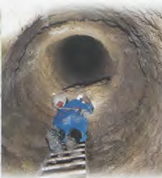
Captage dit de Fromente à Saint-Didier, un puits en construction
