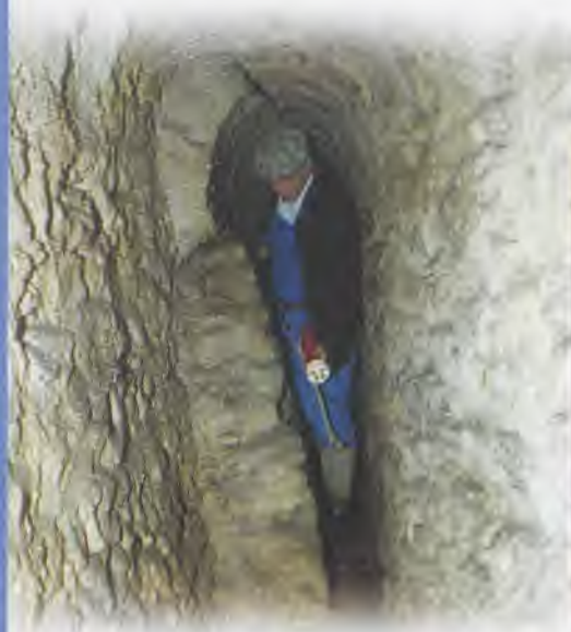
Galerie de captage remaniée à Saint-Romain
